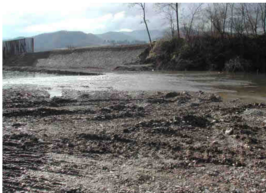
Fig. 11. Impatti temporanei causati dal passaggio di mezzi meccanici (foto E. Pini Prato)
