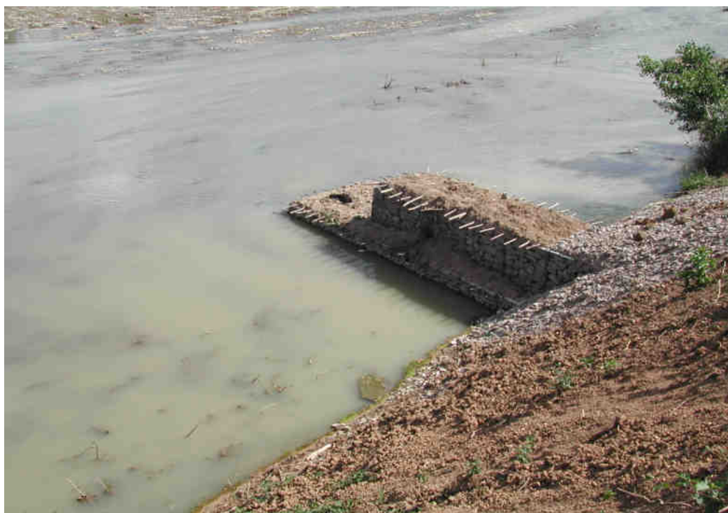
Fig. 15. Torbidità dell'acqua per lavori eseguiti su alveo bagnato (foto E. Pini Prato)
