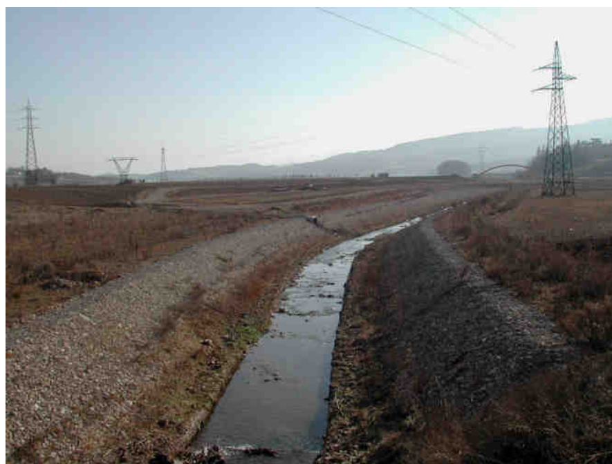
Fig. 22. Rettifica e rivestimento di un corso d'acqua collinare (foto E. Pini Prato)
